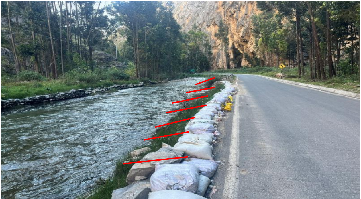
FIGURA N°02: SE OBSERVA QUE EN LA MARGEN IZQUIERDA DEL RIO ALIS, SUFRIÓ UN DESBORDE EL CUAL TRATARON DE MITIGAR COLOCANDO
